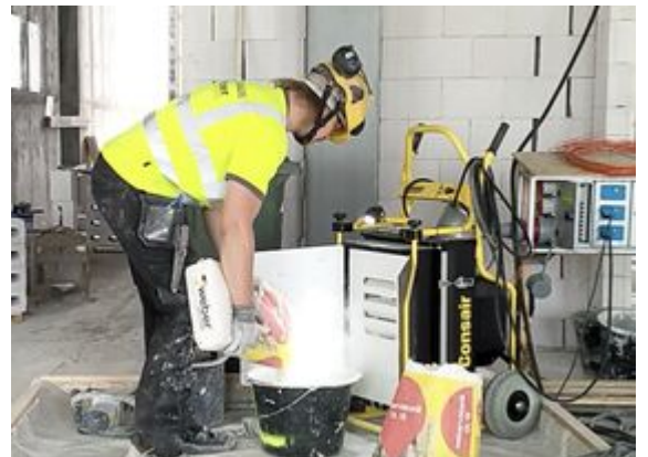
Consair CAMU D2 muuraustyön kohdepoistossa. Käyttäjänä Jani Valio, KJL Muuraus Oy.
